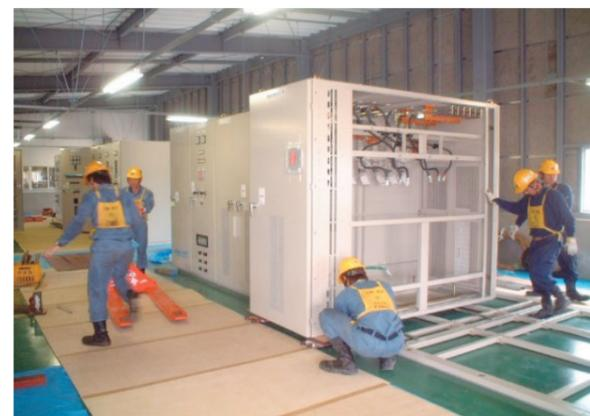
配電盤の搬入から組立までトータルに施工します。既設盤の更新や停電切替作業も計画段階から提案を行い、限られた時間内で品質確保した施工を行います。
